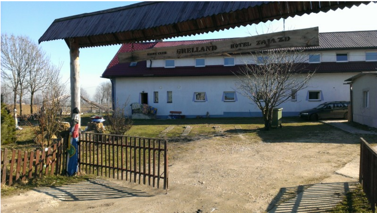
Ilustracja 2: Zabudowana nieruchomość na trasie kolejki (zasypany wykop).
